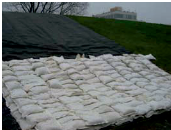
Fotos: THW Emden
