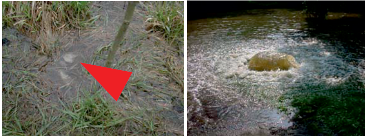
Die Bilder zeigen eine Auswahl von Austrittsstellen auf der Landseite. (Fotos THW Emden)
